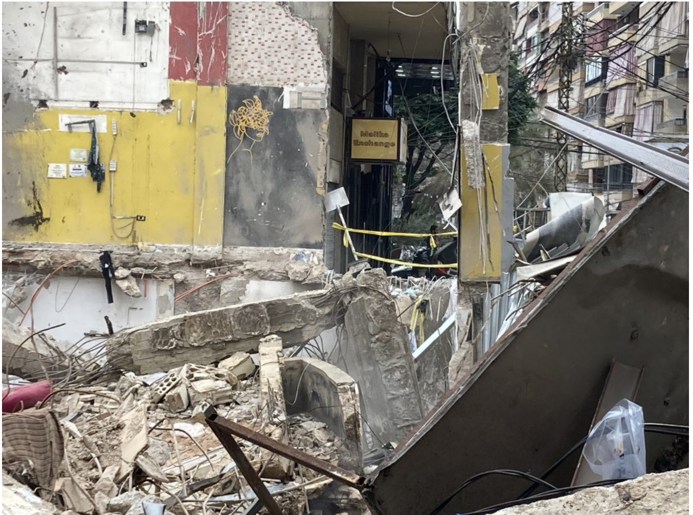
Bild: Südbeirut, Al Qaim Viertel. Hier standen zwei Wohnhäuser mit 8 Stockwerken zerstört von Israel in der Nacht vom 5. auf den 6. Juni 2025. Foto: Karin Leukefeld
