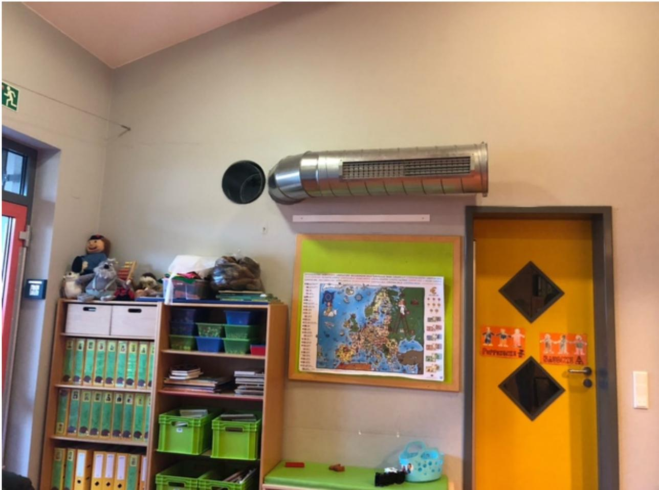
Ein Rohr und eine Fehlbohrung
