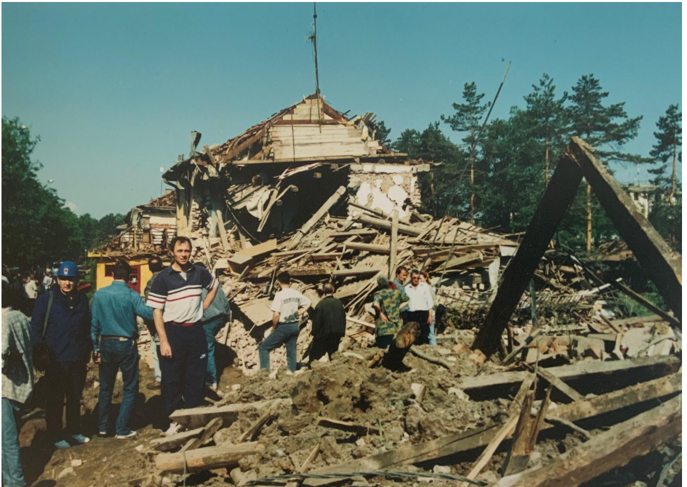
Von Nato-Bomben zerstörtes Gebäude in Valjevo
