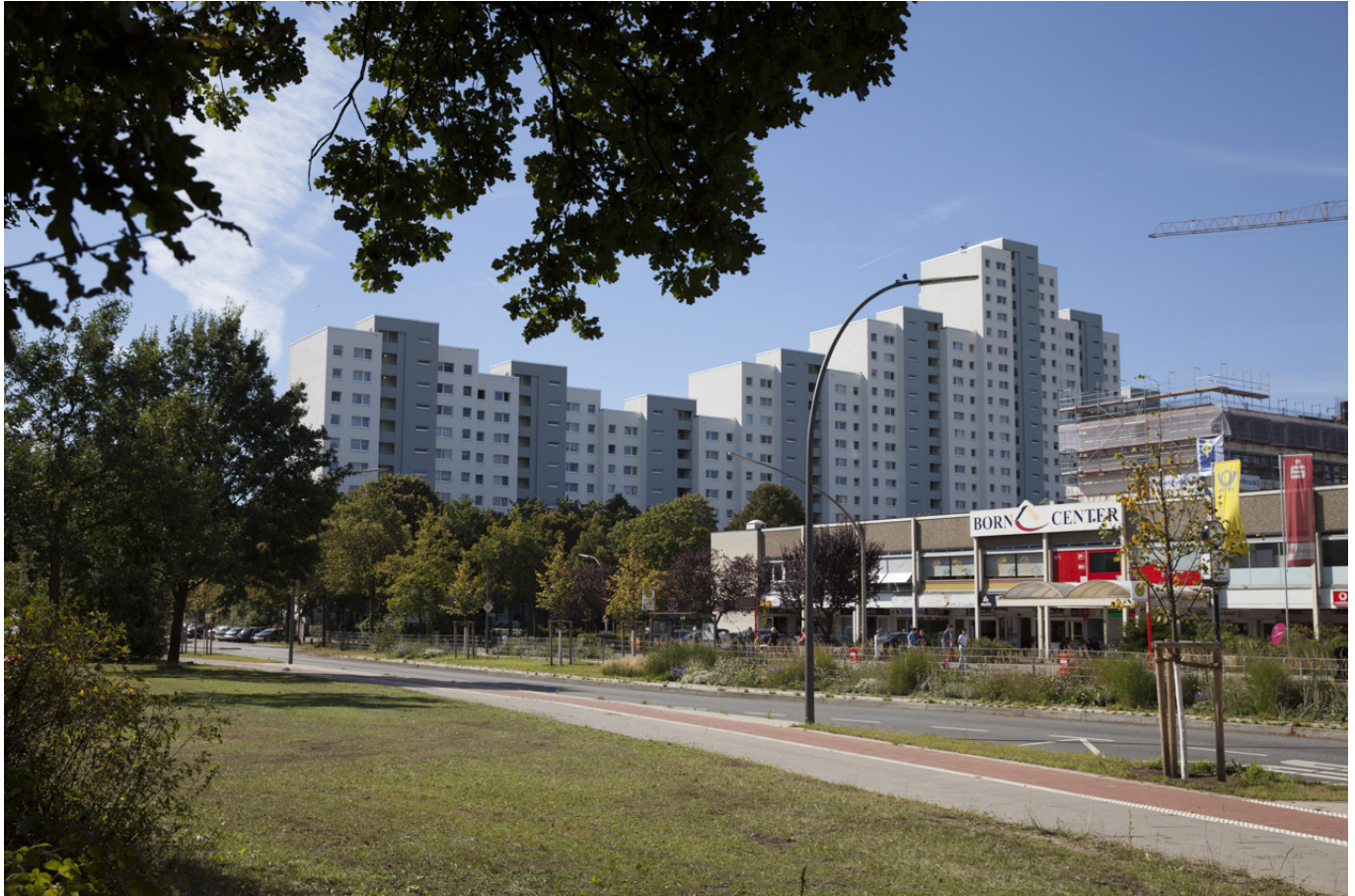
„Moderner Wohnungsbau“ am Osdorfer Born (Foto: ProQuartier)
